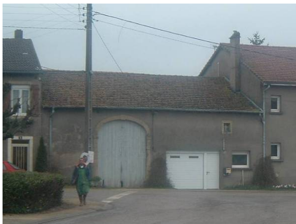
Porte charretière avec clef de voûte
