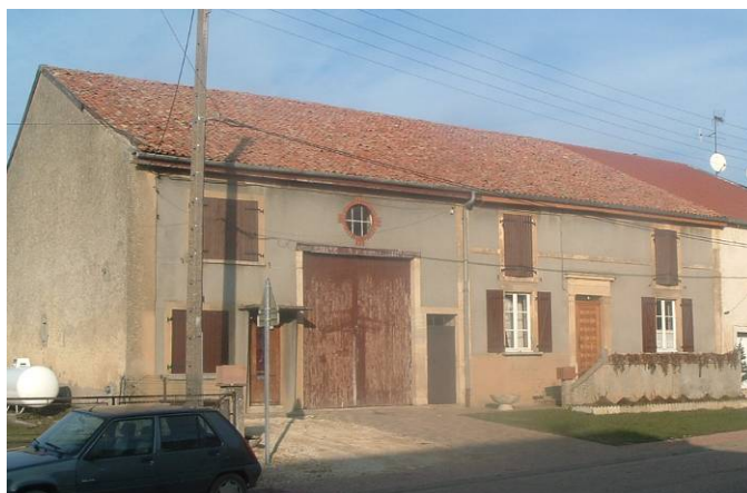
Encadrement de la porte d'entrée, Rythme et dimension des ouvertures
