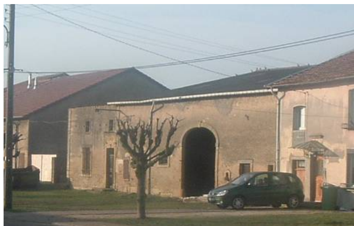
Porte charretière avec clef de voûte, Rythme et dimension des ouvertures
