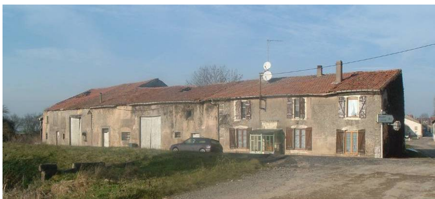
Certaines habitations lorraines ont un aspect délabré et mériteraient une attention particulière pour une réhabilitation tout en conservant leurs caractéristiques traditionnelles.
