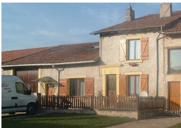
Encadrement de la porte d'entrée, Rythme et dimension des ouvertures
